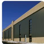
**Modèle de chauffage solaire de l'air** pour les applications de capteurs solaires plans servant au chauffage de l'air de ventilation et au chauffage de l'air de procédé, allant des petites résidences aux larges systèmes de ventilation commerciaux et industriels, en passant par les divers procédés de séchage des récoltes.
