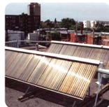
**Modèle de chauffage solaire de l'eau** pour des projets de chauffage de l'eau domestique, de procédés industriels et de piscines (intérieures et extérieures), allant des petits systèmes résidentiels aux larges systèmes commerciaux, institutionnels et industriels.
