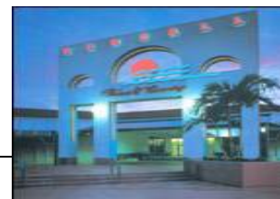
Portes d'entrée dans des secteurs commerciaux
