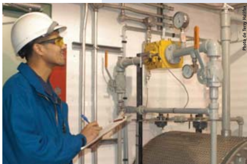
M. Dwayne Hansen, opérateur pour Inuvik Gas Ltd., effectue le relevé d'un compteur de gaz naturel.
