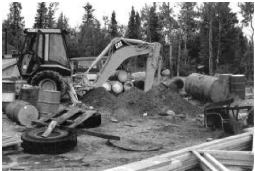
Travaux visant à détecter les problèmes environnementaux.
