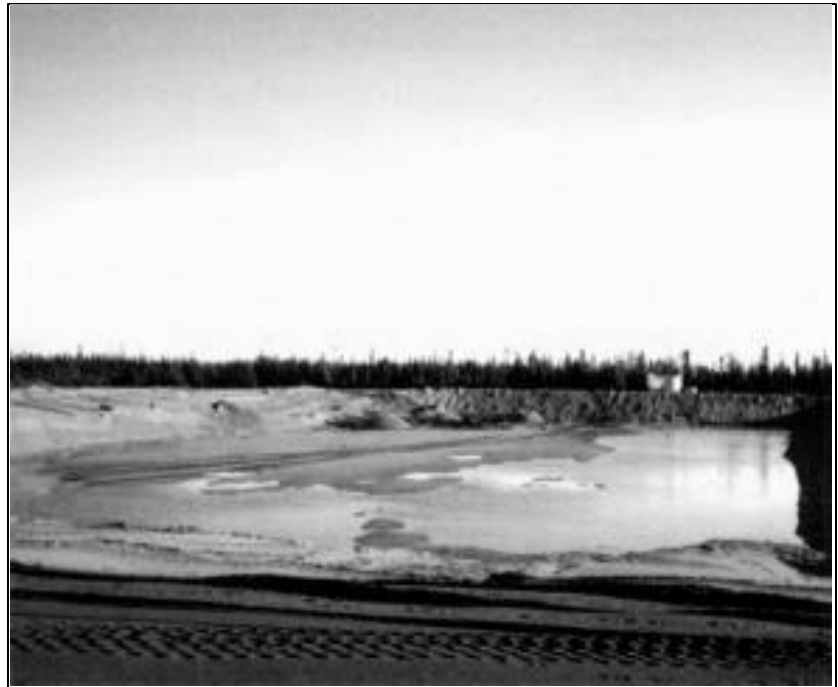
Début de la construction d'un nouveau système d'égout à Chisasibi.
