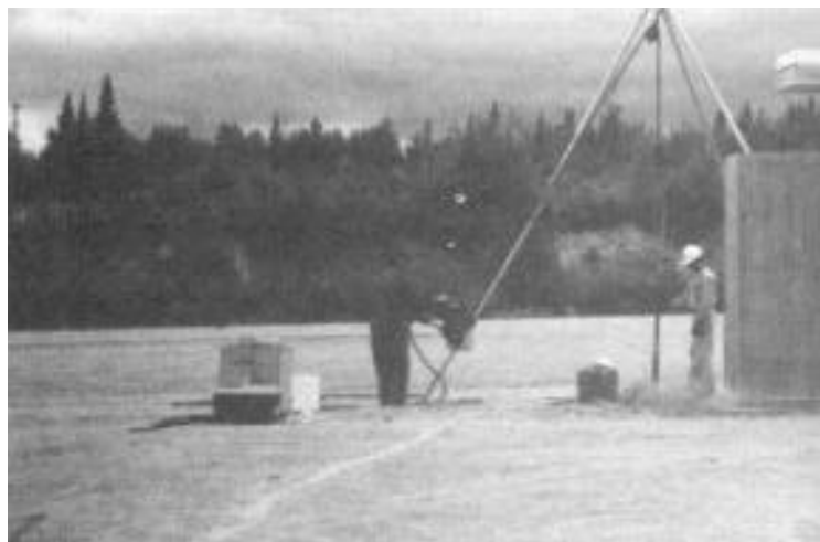
Installation de puits d'observation en vue d'une étude de caractérisation détaillée dans une collectivité crie.
