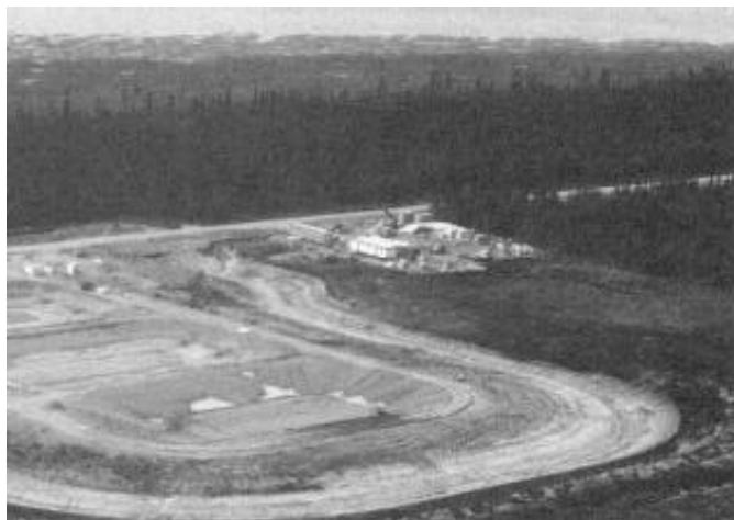
Vue des trois étangs aérés à la fin des travaux d'épuration des eaux usées à Waskaganish.
