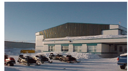
Panneau solaire de l'école secondaire d'Alaittuq - Rankin Inlet Alaittuq
