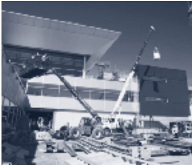
Travaux à l'Aéroport international Pierre-Elliott-Trudeau de Montréal
