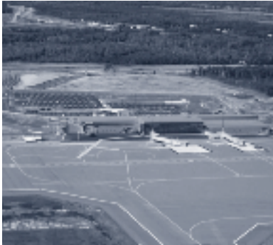
Nouvelle aérogare de l'Aéroport international du Grand Moncton
