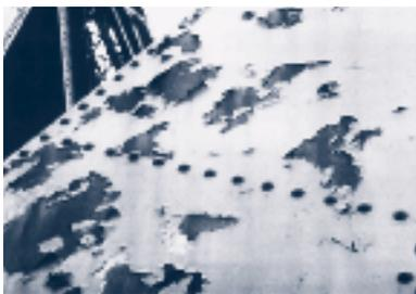
La partie non rénovée du pont présente un problème de corrosion et la peinture est en mauvais état.
