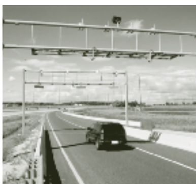
Dispositifs de perception du péage pour les véhicules convergeant vers une route à péage
