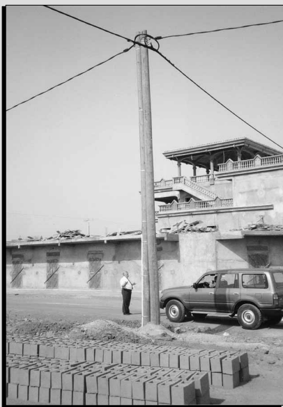
Vue d'un poteau électrique installé dans le cadre du projet de l'ACDI consistant à rénover et à réparer le système de distribution d'électricité à Bamako, au Mali.
