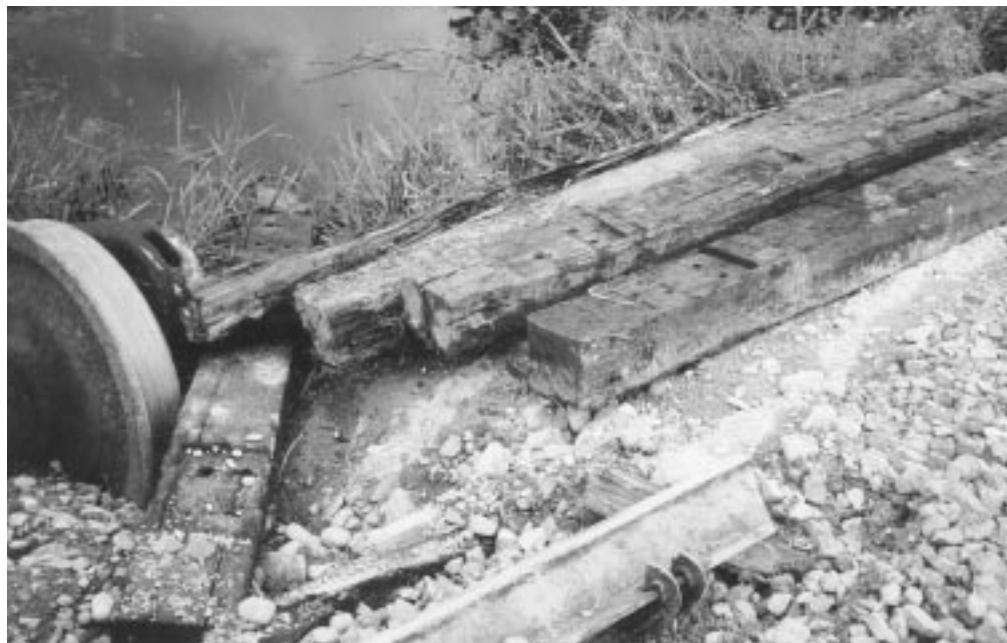
Des traverses brisées, un rail cassé et une partie d'un essieu monté reposent sur l'épaulement de la voie.
