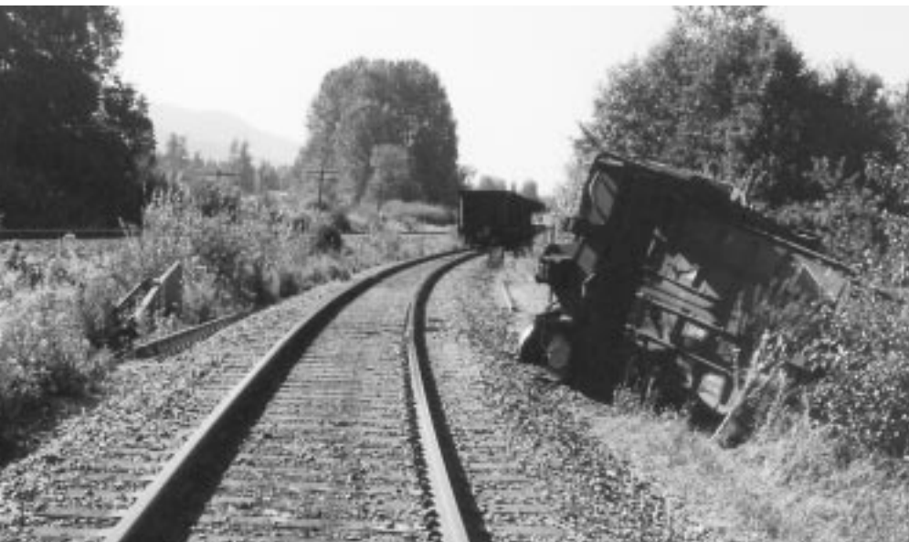
Dernier wagon du train 839 sur le lieu de l'accident.
