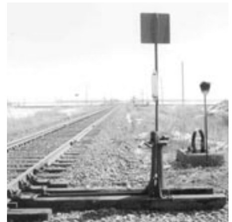
Les photographies du haut montrent que les pointes d'aiguille sont ouvertes de 3/16 de pouce, mais que le signal de CCC montre un feu vert. Les photographies du bas montrent un levier de manœuvre d'aiguillage déverrouillé et partiellement relevé, alors que la cible d'aiguillage est au vert.
