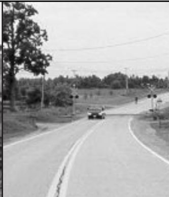
7 Prudence aux passages à niveau
