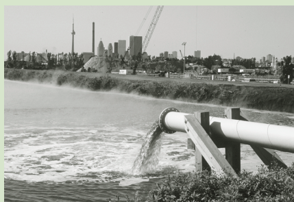
Lagune d'eaux d'égout près de Toronto
