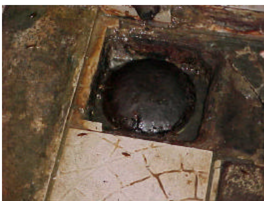
Puisard de cuisine couvert de graisse et infesté d'insectes.
