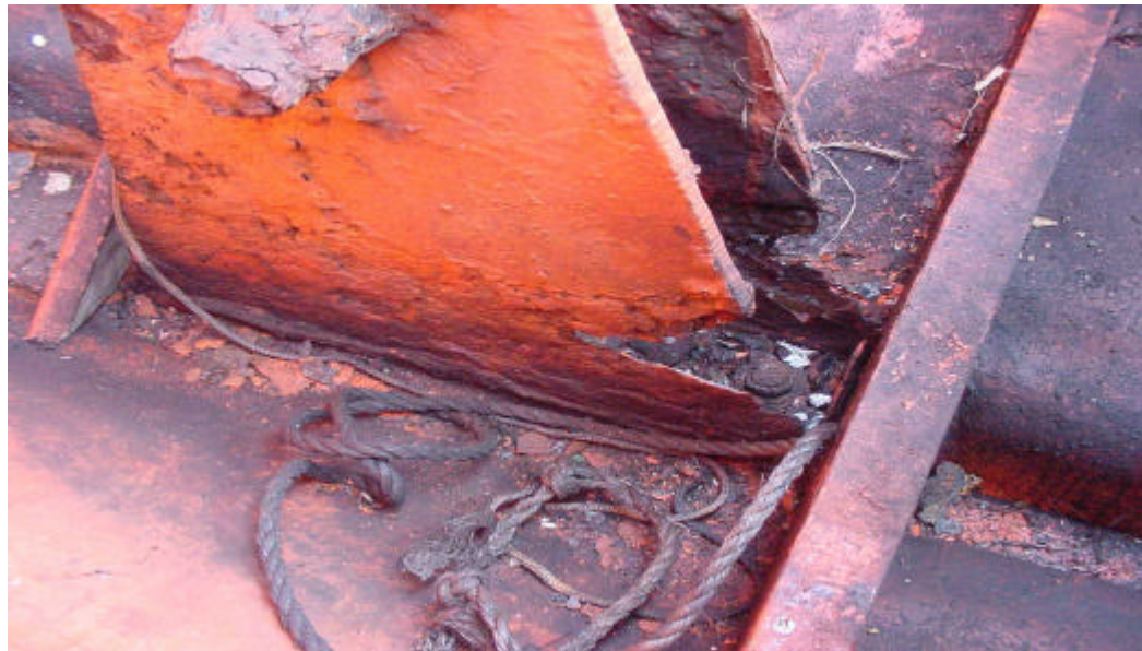
Ferrure de support d'embarcation de sauvetage jugée très corrodée lors d'une inspection de contrôle des navires par l'État du port.
