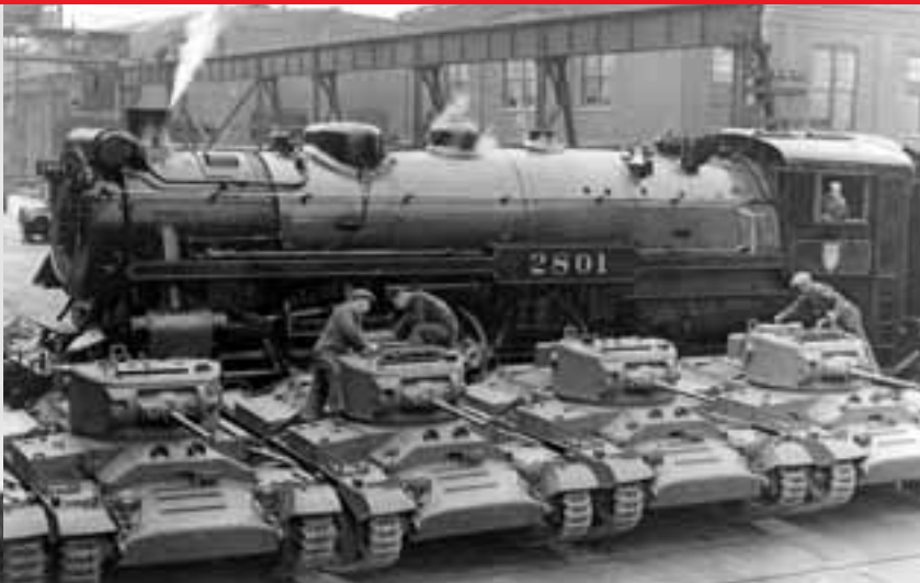
CPR's Angus Shops in Montréal produced 1,420 16-ton "Valentine" army tanks. / Les ateliers Angus du CFCP ont produit 1 420 chars d'assaut Valentin de 16 tonnes.
