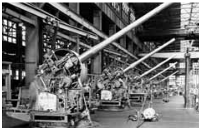
CPR Ogden Shops’ World War II production included 6-pounders, 12-pounders and these 4-inch Mark XXIV gun mounts./Parmi les armements fabriqués aux ateliers Ogden du CFPC, durant la Seconde Guerre mondiale : des obus de 6 et 12 lb, et ces montures à canons Mark XXIV d’un calibre de 4 pouces. CANADIAN PACIFIC RAILWAY ARCHIVES — IMAGE NO. A.27254
