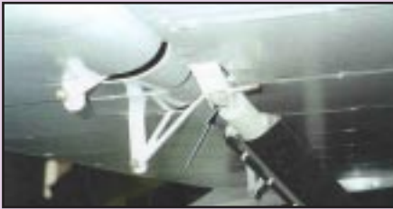
Extrémité supérieure d'un hauban arrière typique fixant l'aile sur un appareil de type similaire.
