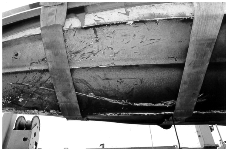
Photo 4 Coque endommagée du Sunboy
