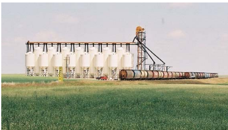
Figure 50 : L'installation de chargement des wagons des producteurs exemptée de permis exploitée par la West Central Road and Rail Ltd. à Eston (Saskatchewan).
