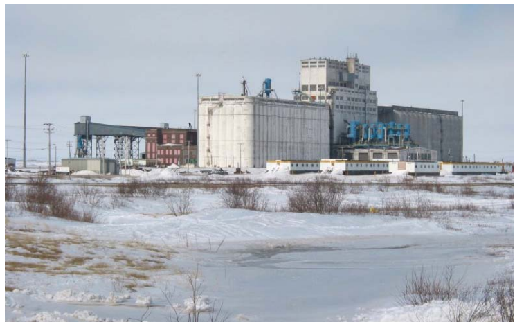
Figure 52 : Silo terminus exploité par la Hudson Bay Port Company à Churchill (Manitoba).
