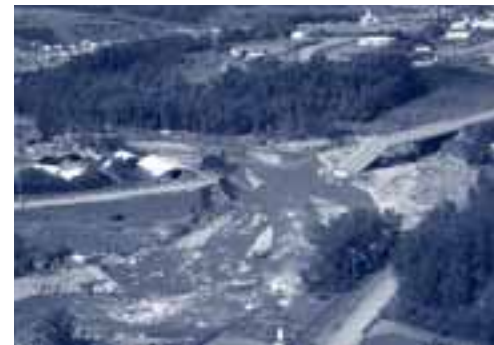
Pont effondré et érosion des rives le long de la rivière à Mars, basses-terres du Saguenay, Québec, suite à l'inondation de juillet 1996. Date de la photo : 27 juillet 1996.
