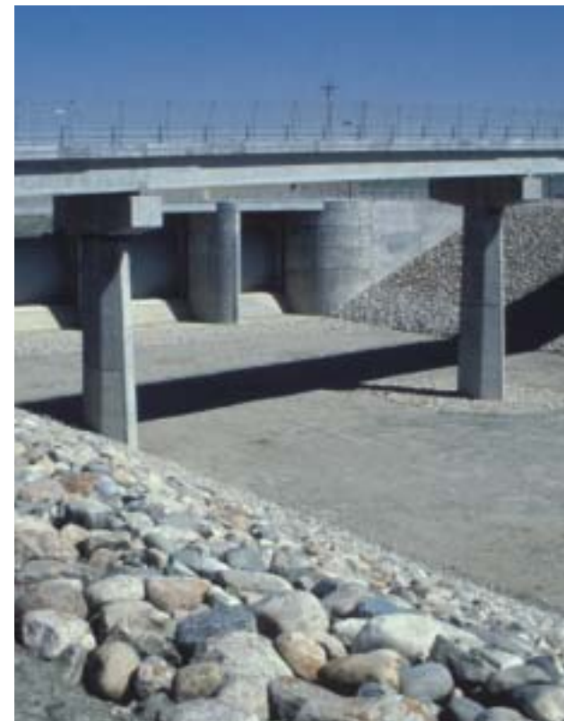
Le canal du réservoir St.-Mary près de Spring Coulee, Alberta, après 66 jours sans pluie, été 2001.
