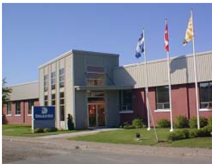
Delastek – Grand-Mère Quebec
