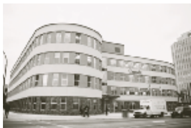
L'édifice Greenstone à Yellowknife est l'un des édifices auquel Travaux publics et Services gouvernementaux Canada travaille afin de s'assurer qu'il obtienne la plus haute cote d'efficacité énergétique.
