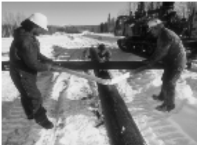
Des ouvriers montent une traverse sur un poteau en bois, qui servira à la ligne de transport d'électricité.
