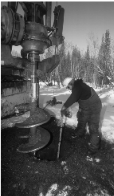
Les conditions du sol peuvent avoir une incidence sur l'installation des poteaux en bois.
