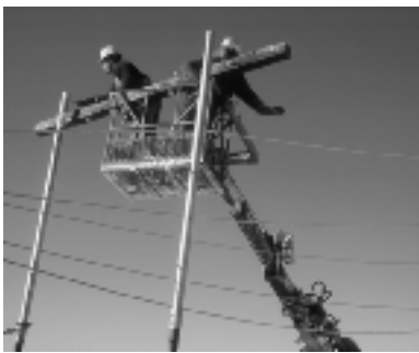
Des ouvriers installent la ligne de transport d'électricité.
