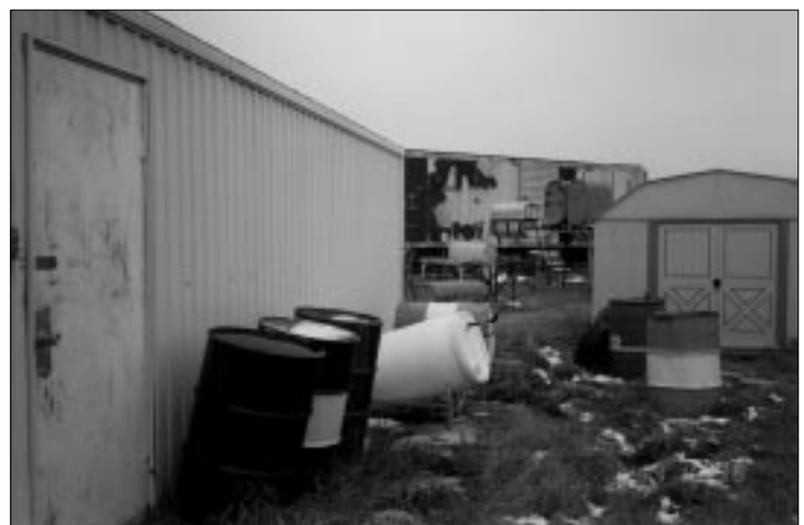
Barils d'huile, de solvants et de WD10 gardés sur de l'herbe, sans confinement secondaire, à côté d'un garage à Cold Lake.
