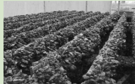
Le nettoyage des prises d'eau et d'autres pièces d'équipement infestées par la moule zébrée, comme ces grilles antidébris, coûte des millions de dollars par année.
