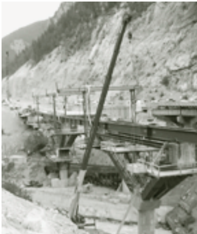
Construction du pont de 5-Mile (Yoho), dans le col Kicking Horse, en Colombie-Britannique – projet réalisé dans le cadre du Programme stratégique d'infrastructures routières
