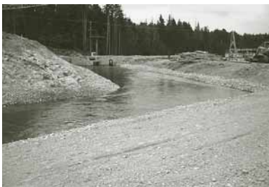
Ce projet d'aménagement prévoit l'érection de barrières sur les berges pour lutter contre l'érosion du sol et empêcher ainsi le sol d'être transporté jusque dans les frayères des saumons.
