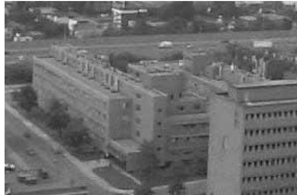
On utilise mieux l'espace disponible au 555, rue Booth en vue de la désaffectation éventuelle des bâtiments plus anciens, tels que le 550 et le 552, rue Booth.
