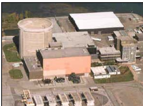
Figure 5.5 Installation de gestion des déchets de Gentilly-1
