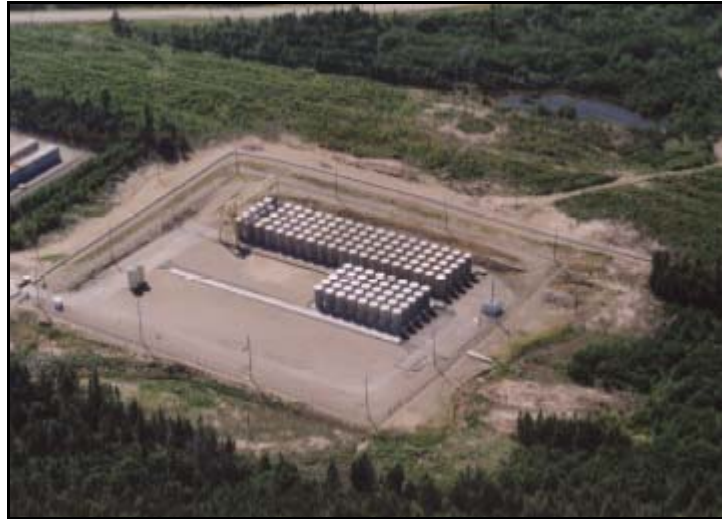
Figure 4.8 Zone de stockage à sec du combustible usé de Point Lepreau
