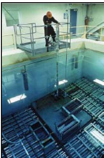
Figure 4.1 Stockage en piscine à la centrale nucléaire de Pickering
