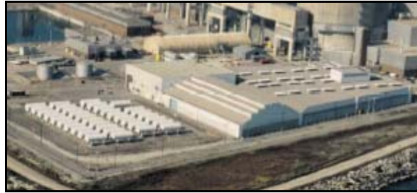
Figure 5.1 Installation de gestion des déchets de Pickering avec la ZSCT à gauche et la zone de stockage à sec du combustible usé à droite
