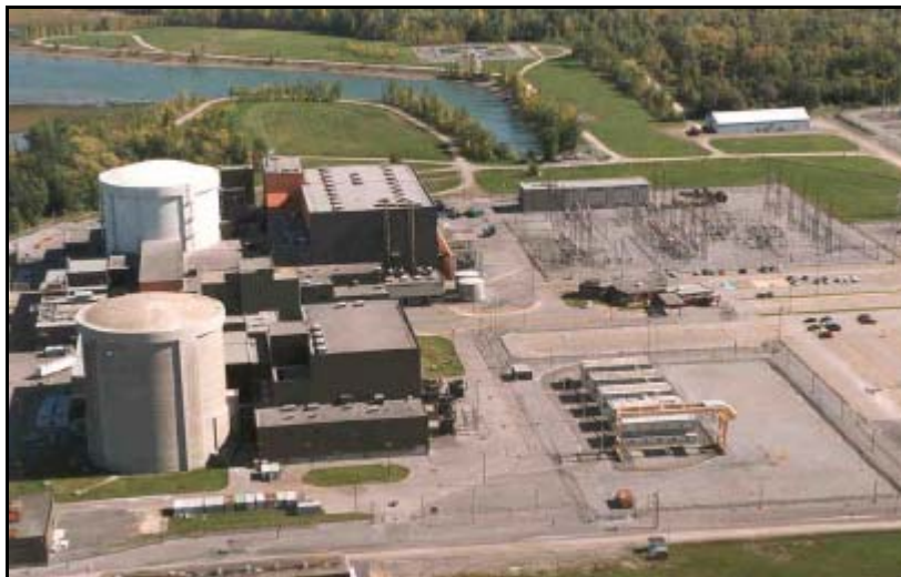
Figure 4.7 Installation de stockage à sec du combustible usé de Gentilly-2 (au bas de la photo, à droite)
