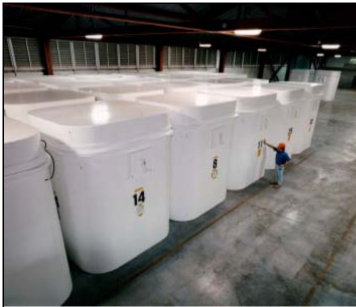
Figure 4.4 Conteneurs de stockage à sec à Pickering
