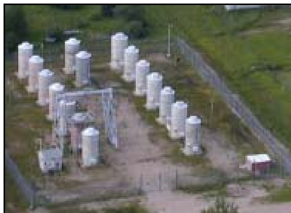
Figure 4.10 Silos actuels des Laboratoires de Whiteshell
