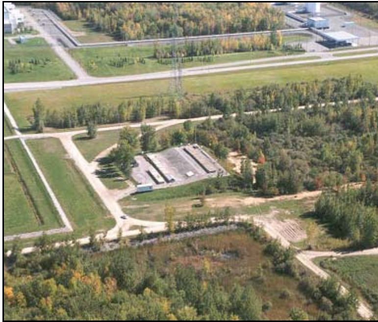
Figure 5.3 Installation de gestion des déchets d'Hydro-Québec
