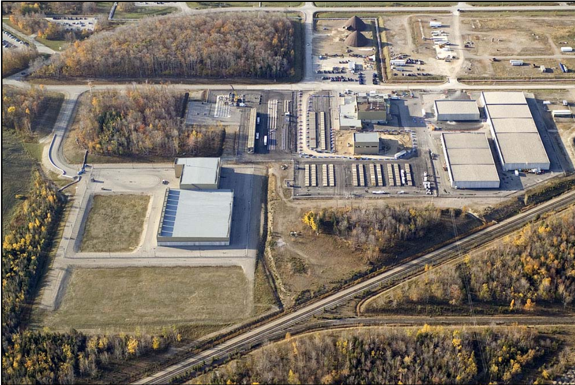
Figure 5.2 Installation de gestion des déchets Western
