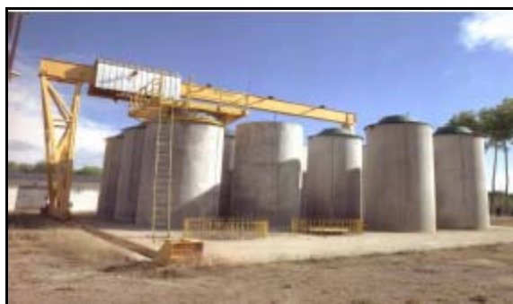
Figure 4.2 Silos en béton d'EACL
