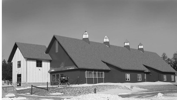
La construction d'une nouvelle grange-étable pour chevaux et bovins s'est achevée en décembre.
