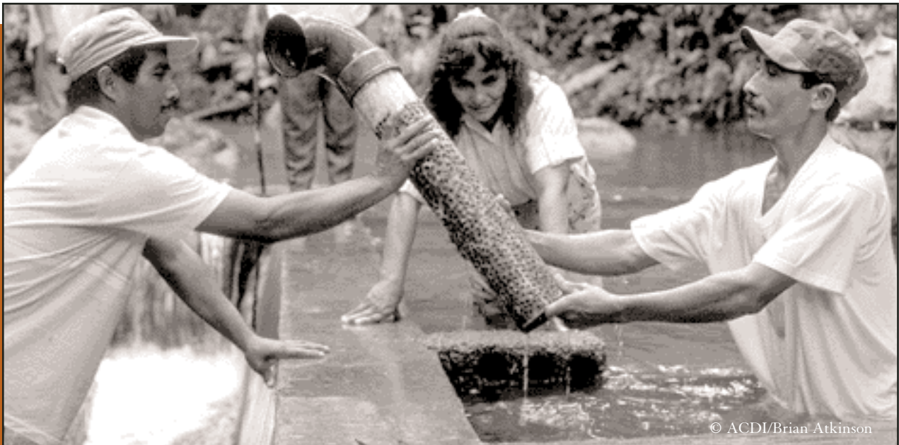
À Palos de Agua, au Honduras, des travailleurs nettoient les filtres d'un barrage dans le cadre d'un projet d'approvisionnement durable en eau et d'assainissement.
