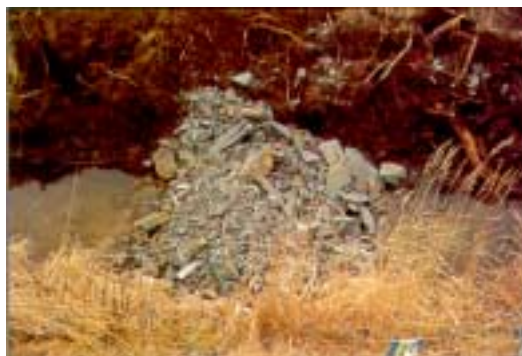
Barrage de correction en roche assurant la protection d'un point bas.
