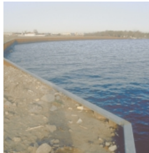
L'usage de murs de soutènement verticaux offre peu d'habitat pour le poisson.
