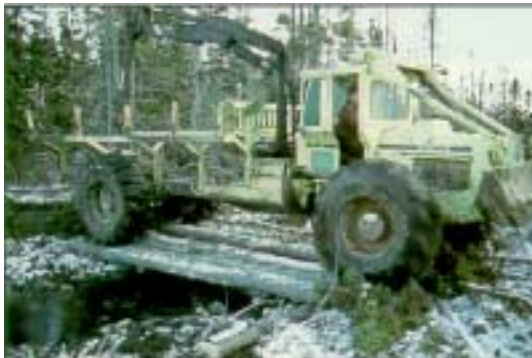
Les ponts temporaires sont économiques et faciles à installer, et protègent l'habitat du poisson.
