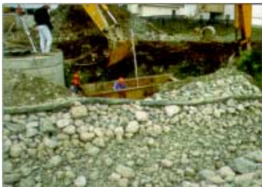
Lit de cours d'eau remis en état
