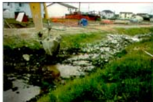
Excavation pratiquée dans un cours d'eau
