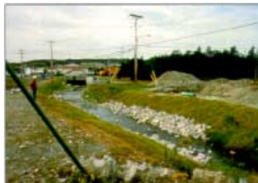
Traversée de cours d'eau achevée
