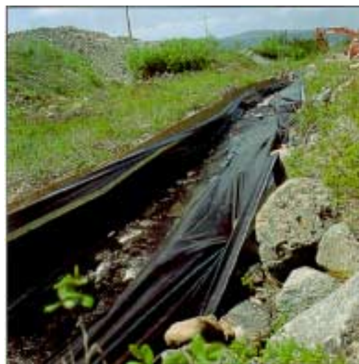
Canal de dérivation temporaire avec membrane
