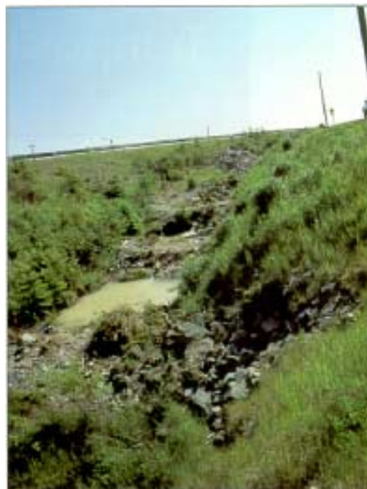
Série de bassins de décantation grossiers à usage temporaire.
