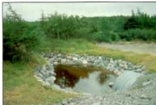
Remodelage des rives d'un cours d'eau – enrochement, gazon et végétation naturelle
