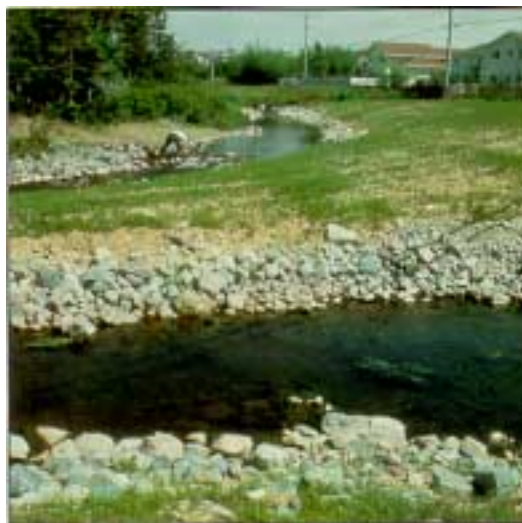
Stabilisation des rives d'un cours d'eau par enrochement et hydroensemencement
