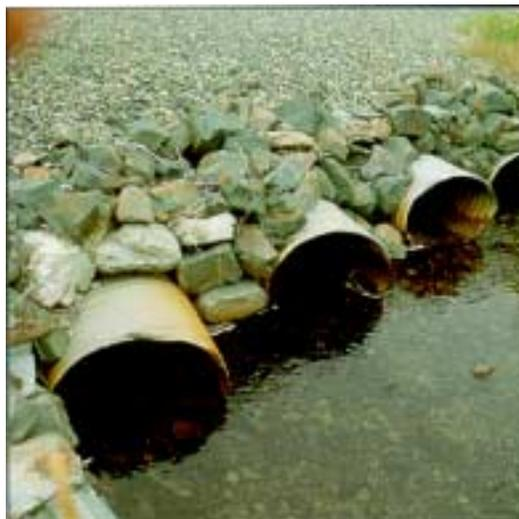
*Stabilisation des sorties de ponceau avec un enrochement*
