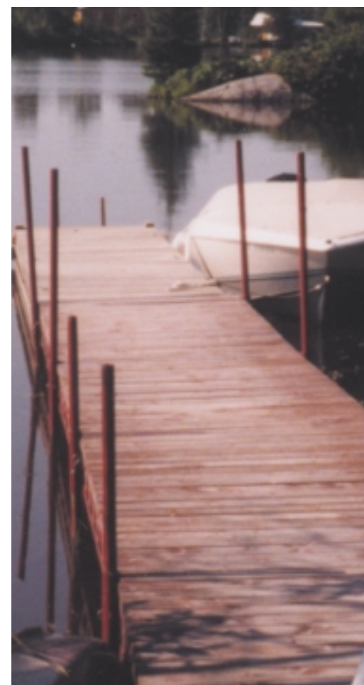
Les quais soutenus par des poteaux causent un minimum de perturbation dans le fond des lacs et des rivières.
