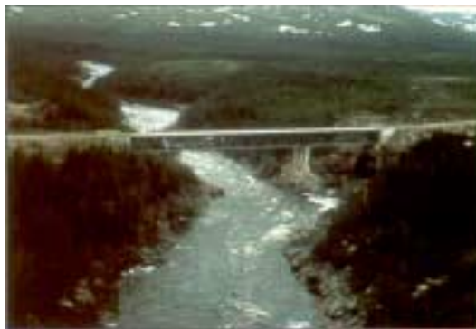
Construction d'un pont.
