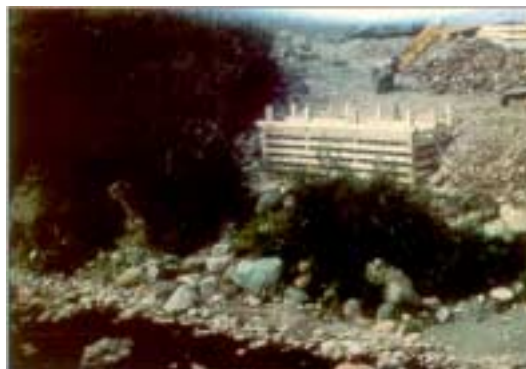
Culée de pont à l'extérieur de la zone mouillée du cours d'eau.
