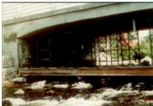
Ouvrage provisoire pour soutenir le tablier de pont en béton.
