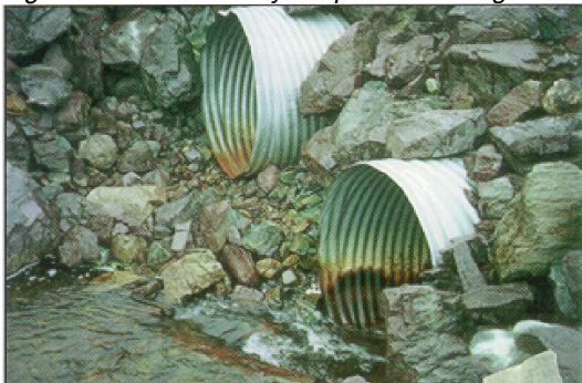
Figure 4 Ponceau à tuyaux parallèles étagés
