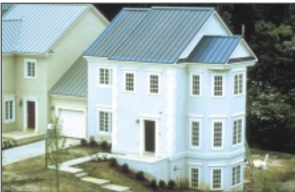
Système solaire de toit en Maryland. (© United Solar Systems Corp. USA)
