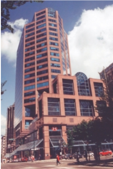
Figure 3 – Immeuble à bureaux
