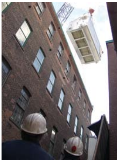
Installation d'une unité énergétique au biogaz, Cascades Groupe Papiers Fins
