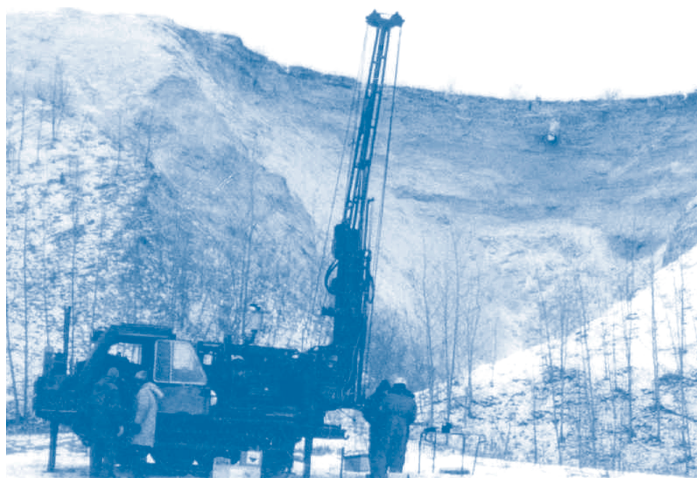
Digue en mode de rupture progressive — des travailleurs procèdent à des essais pour déterminer les propriétés des matériaux.
