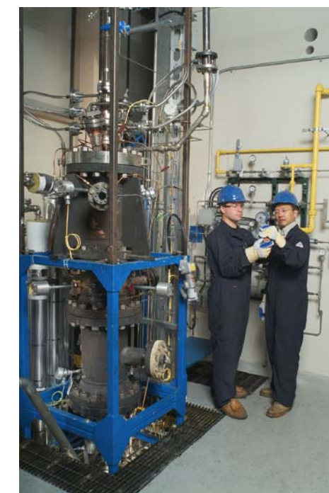
Gazogène à pression contrôlée du GPEE.
