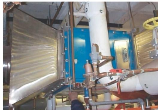
Figure 3 – Économiseur de cheminée installé sur une cheminée d'aération de chaudière
