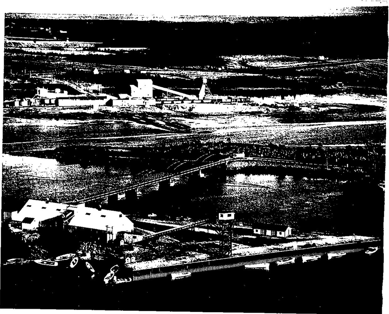
L'exploitation de sel de la *Canadian Rock Salt Company Limited*, à Pugwash (N.-É.). On peut voir le chevalement d'extraction et l'atelier de tamisage (arrière-plan centre), l'atelier d'évaporation (arrière-plan gauche) et les entrepôts et quais d'expédition (avant-plan).
